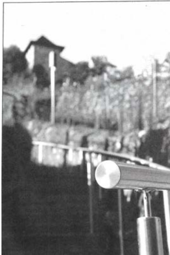
Neues Treppengeländer dem Rebberg entlang zum Schlössli 2014
